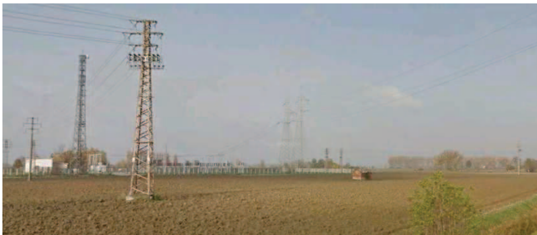
Vista sugli elettrodotti presenti nel comune di Cella Dati
